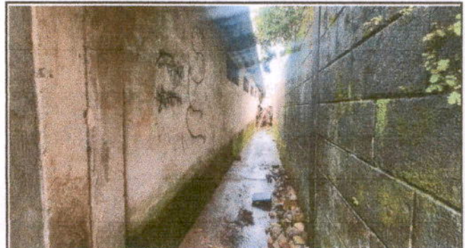
Foto 4: MÓDULO 2 REPARACION DE REPELLO Y CERNIDO DE PAREDES: Repello en muro
